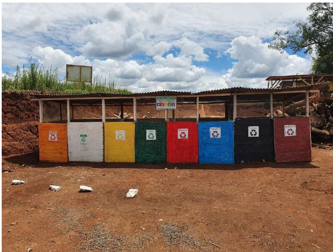
Figura 6 - Exemplo de resíduos sólidos acondicionados corretamente em obra.
