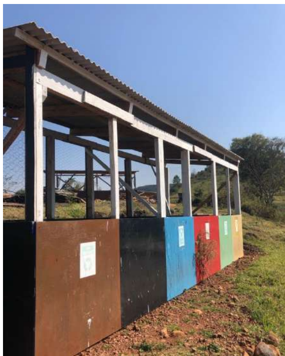
Figura 6 - Baias de armazenamento de resíduos.
