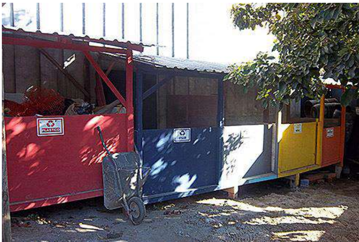
Figura 7 - Exemplo de resíduos sólidos acondicionados corretamente em obra.
