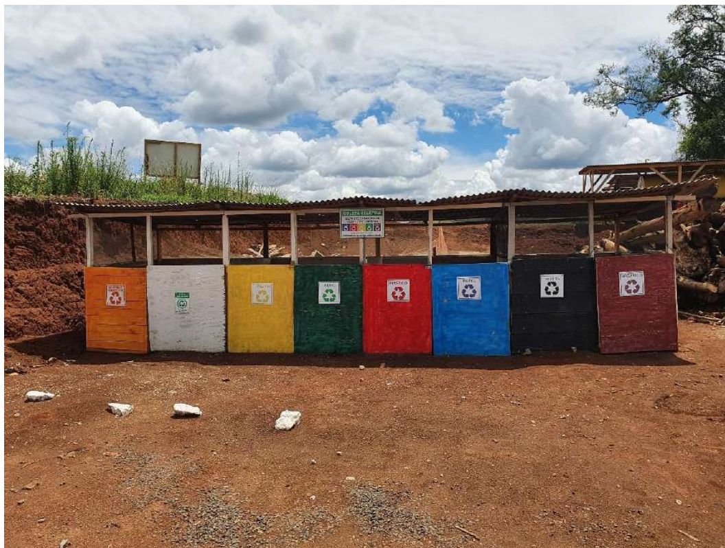
Figura 5 - Exemplo de resíduos sólidos acondicionados corretamente em obra.
