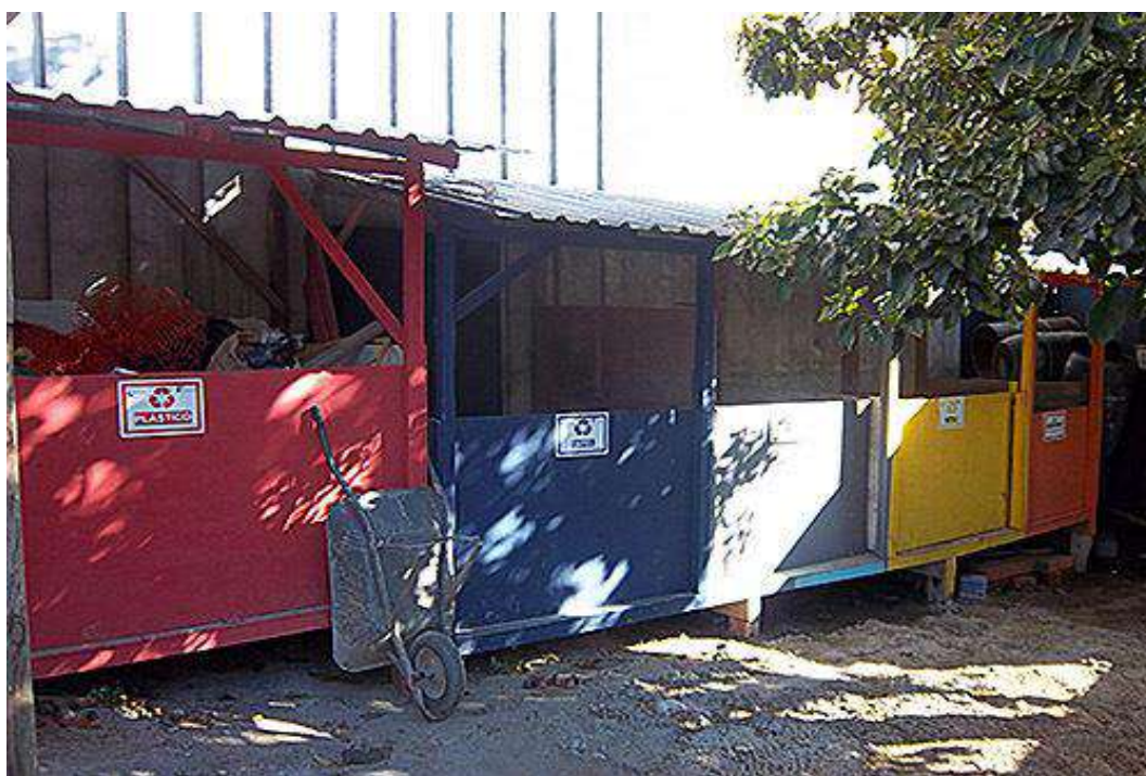
Figura 6 - Exemplo de resíduos sólidos acondicionados corretamente em obra.
